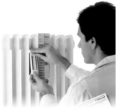
Abb. 4: Montage von Heizkostenverteilern. Wichtig ist die richtige Montagehöhe und die Einheitlichkeit in einem Gebäude.
