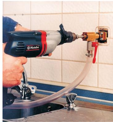
Abb. 8 und 9: Die Modernisierung der alten Warmwasserkostenverteiler ist einfach und ohne Eingriff an der Leitungsführung möglich. Dazu wird lediglich der ursprünglicher Verteiler demontiert. Mit einem speziellen Bohrverfahren wird das vorhandene Venturi-T-Stück dann für die Montage des geeichten Warmwasserzählers MINOCONTROL vorbereitet.
