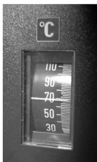
Abb. 5: Oft mit der Warmwassertemperatur verwechselt, zeigt diese Skale jedoch die Kesseltemperatur.
